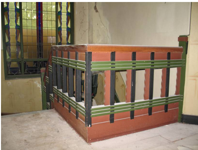
Afb. 38, afb. 39 en afb. 40 Trappenhuis/overloop
