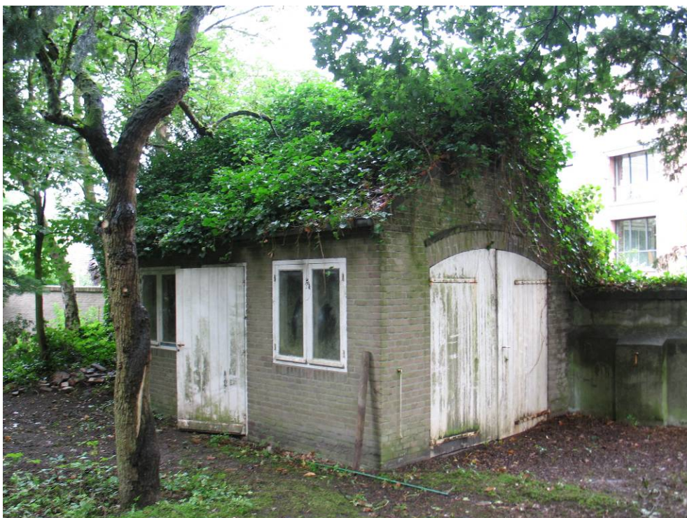
Afb. 47 en afb. 48 Tuin met garage
